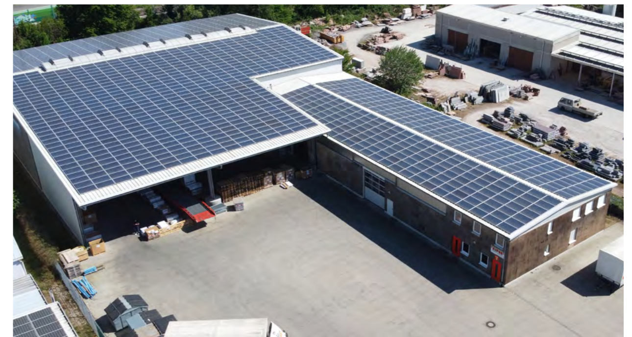
Abbildung 15: Kork-Fassade und PV-Anlage beim Zipse Standort Kenzingen
