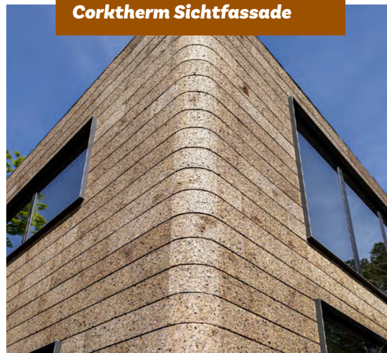
Abbildung 3: Fassade eines Gebäudes aus Kork
